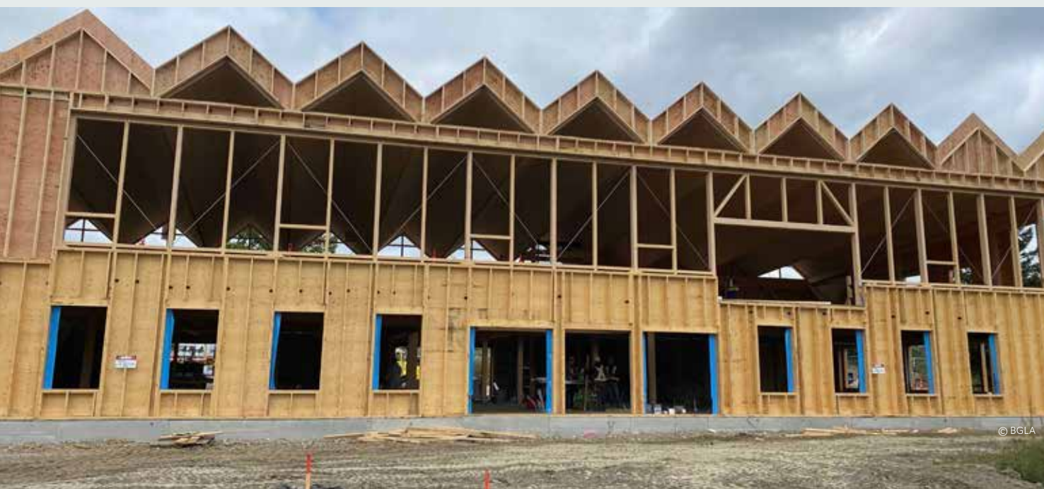
EXTÉRIEUR DU CHANTIER DE L'HÔTEL DE VILLE LA PÊCHE
