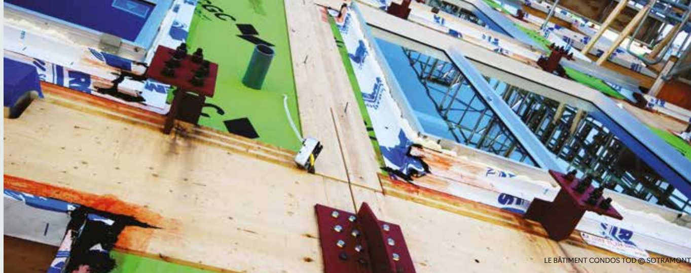
VU D'UN MUR DE REFEND EN CLT
