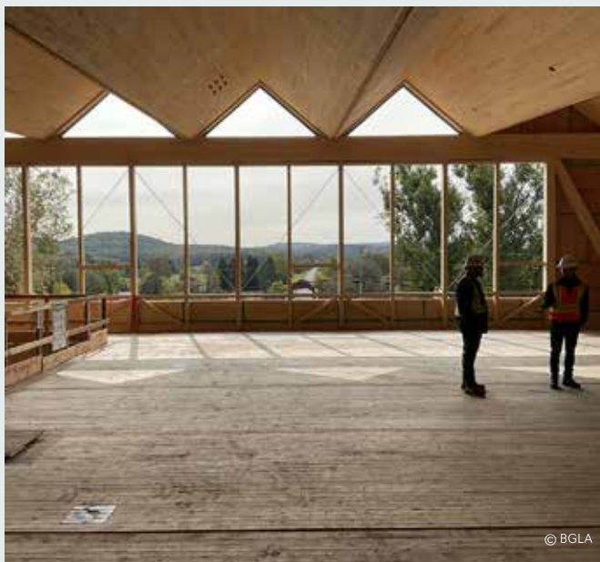
INTÉRIEUR DU CHANTIER DE L'HÔTEL DE VILLE LA PÊCHE
